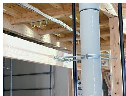
**耐火二層管の告示化** 中規模木造準耐火構造
